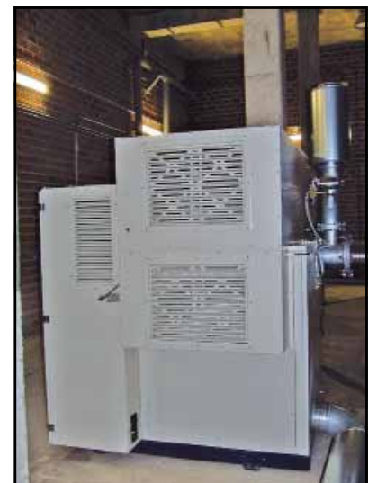
Figura 5. Turbocompresor con sistema de levitación magnético.
