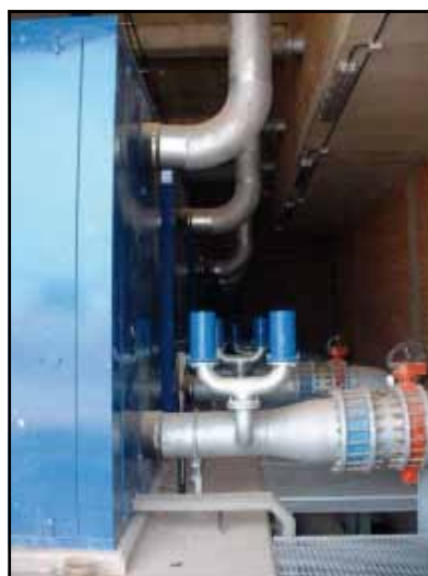
Figura 4. Soplantes de émbolos rotativos.
