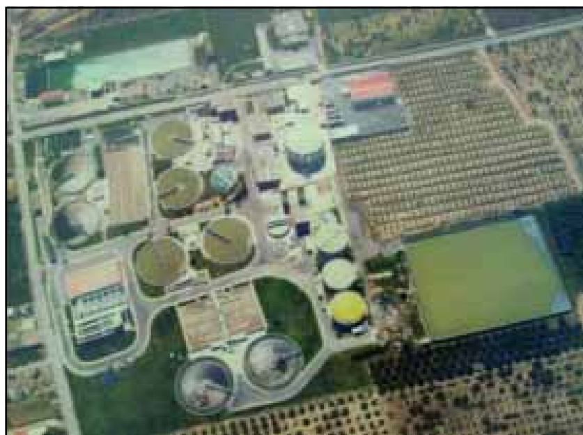
Figura 2. Vista aérea de la EDAR de Castellón.
